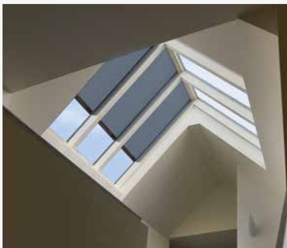
Topfix [S. 160] – horizontaler windfester Sonnenschutz für Oberlichter
