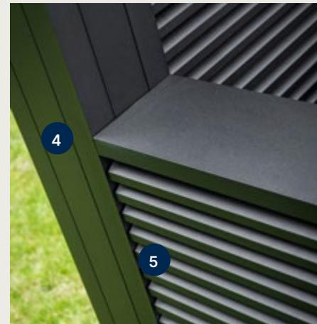
4 WAND WIRD AN BEIDEN SEITEN BÜNDIG MIT DEN PFOSTEN VERARBEITET
